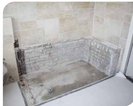
Duschwanne setzen und ausrichten
