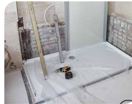
Anschlussarbeiten für Armatur, Wasser und Ablauf durchführen
