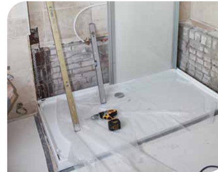
Anschlussarbeiten für Armatur, Wasser und Ablauf durchführen
