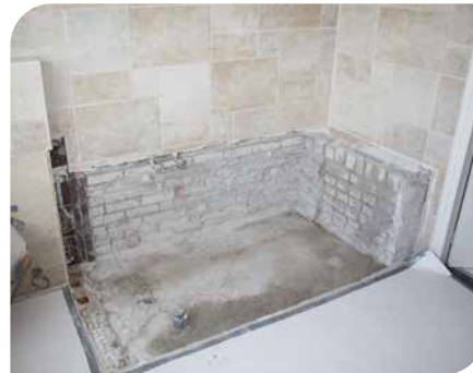
Duschwanne setzen und ausrichten
