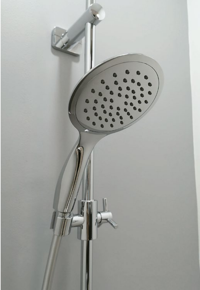
Handbrause mit einstellbaren Düsen
